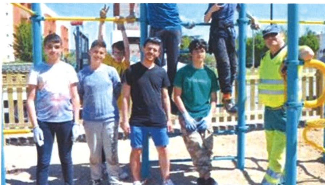
Pour 15 jeunes du quartier, le chantier va financer les prochaines vacances. Photo DDM
